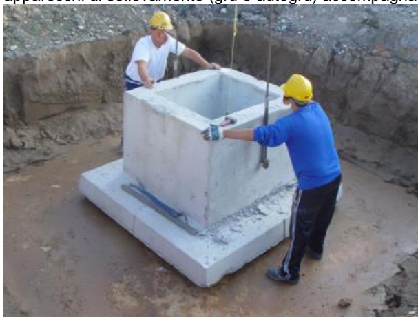
POSIZIONAMENTO DI MASSIMA PLINTO CON AUTOGRU
