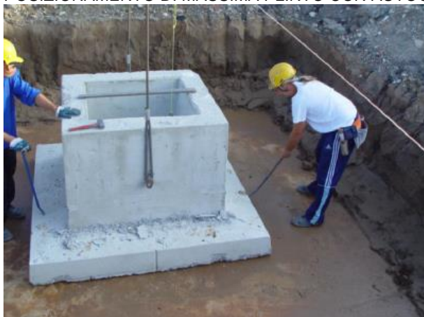
POSIZIONAMENTO FINALE PLINTO CON LEVERINI
